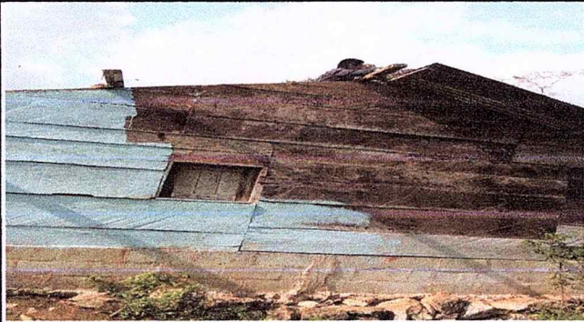
Foto 3: CAMBIO DE ESTRUCTURA DE MADERA POR METAL
