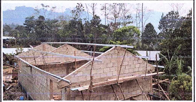
Foto 2: ESTRUCTURA DE TECHO EN INSTALACION
