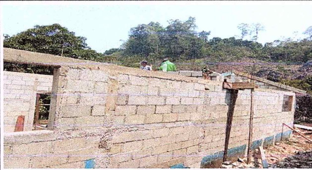
Foto 1: MEJORAMIENTO EN PAREDES DE MODULOS
