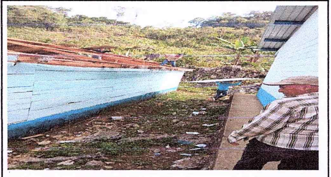
Foto 4: MEJORAMIENTO DE ENTECHADO
